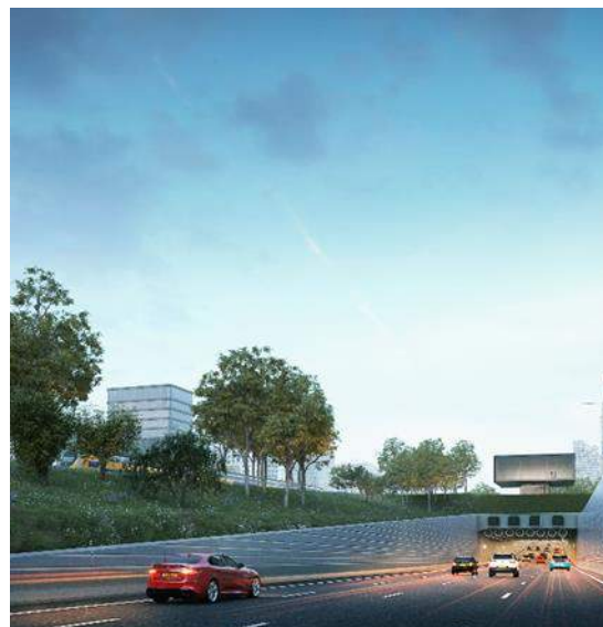
Tunnel In voorbereiding
